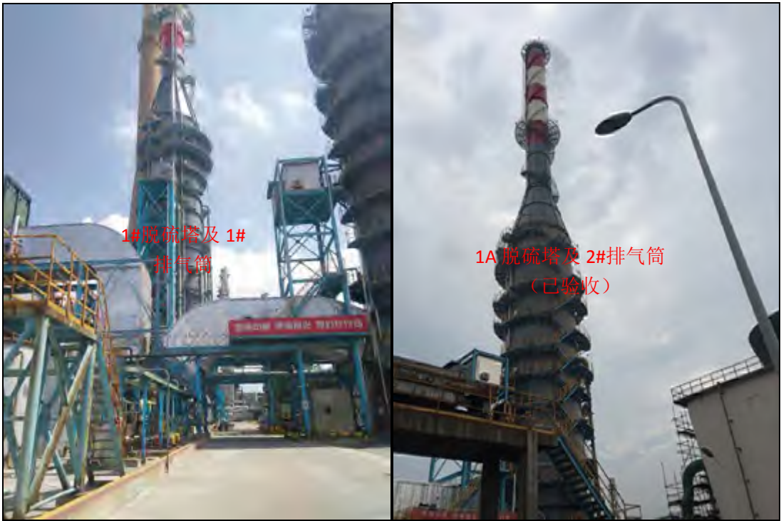
图 3-1 技改项目脱硫塔建设情况
