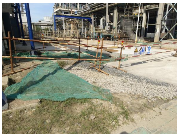
CSW009 周边施工情况
