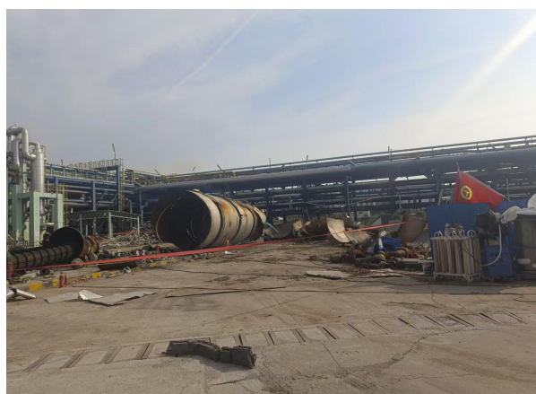
ASW004 周边装置拆除施工
